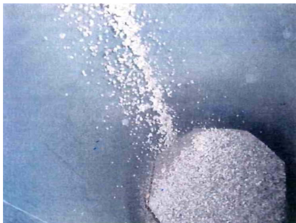
foto 20: Dokumentace obsypávání vrtu.
