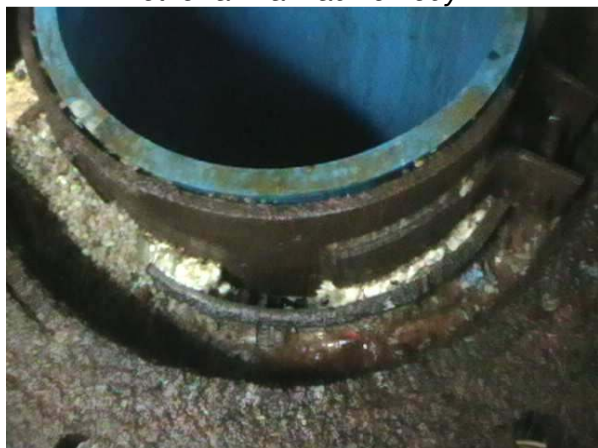
foto19: Virtuální obsyp vrtu, vlevo obsyp přecházející do polyuretanu (žlutý), uprostřed otvor až na hladinu vody.
