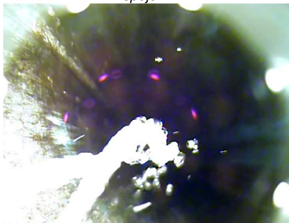
foto 12: Přítok vody do vrtu netěsným spojem.
